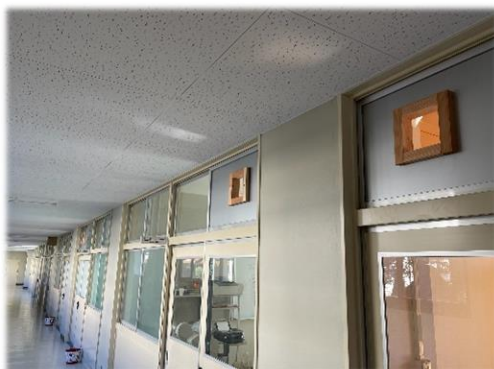
↑換気扇を設置する前です。四角の木枠に換気扇が入ります。
