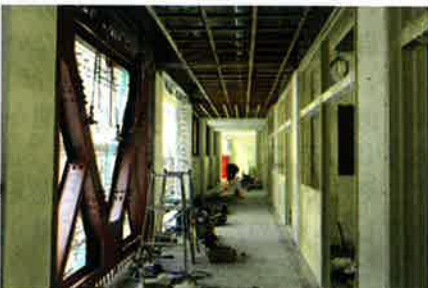
1棟筋交い工事
