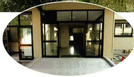
バリアフリー化した1棟への渡り廊下
