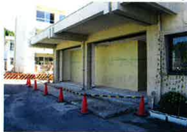
生徒昇降口バリアフリー化工事
